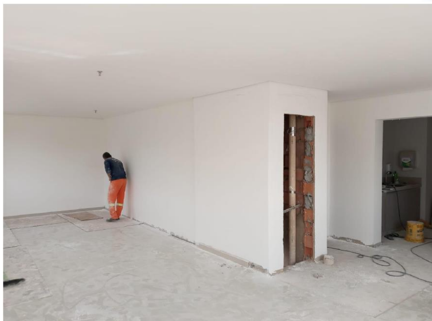
Foto 2 - Ampliação da Clínica de Odontologia
